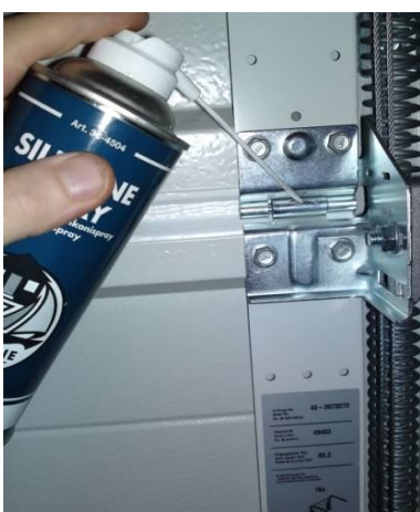
Nr 4: Gångjärn på rullhållare. Detta gäller alla gångjärn/rullhållare! 6st: 3st höger + 3st vänster
