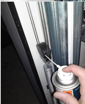
Nr 3b: Detta är ett alternativ till föregående bild enda skillnaden är att smörjningen görs när port är i öppet läge 2st: höger + vänster
