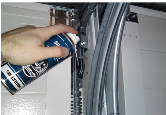
Nr 3b: Vajerhjulaxeln på fjädern. 2st: höger + vänster
