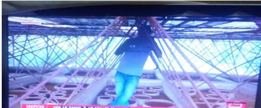
Fig 5 : Charpente installée collectivement par les habitants du village
