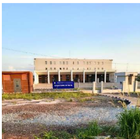
Figure 2 : nouvelle Cour d'appel de Daloa
