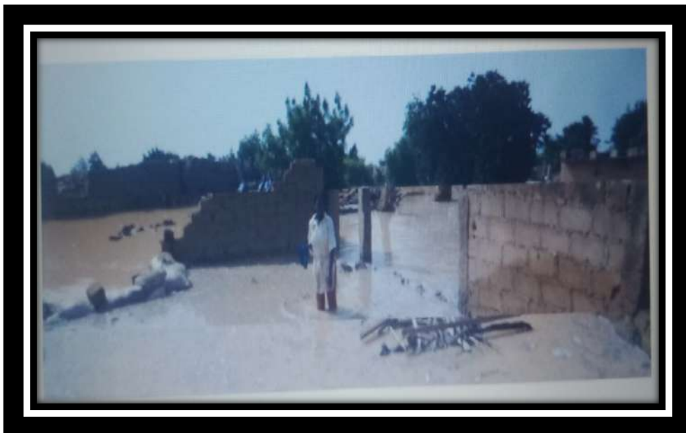
Figure n°3: Inondation de Niamey détruisant des maisons à Harobanda en 2012
