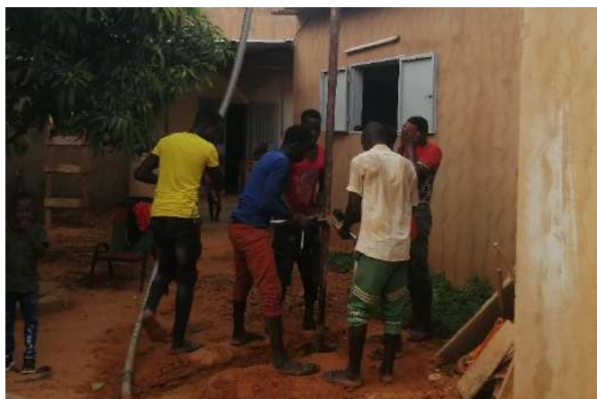
Figure 7 : fonçage manuel-artisanal d'un forage à Saguia, mars 2022
