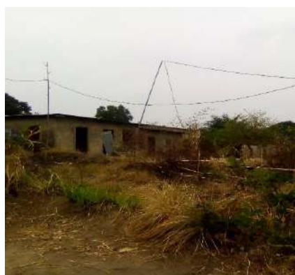
Photo n°2 : Utilisation des poteaux hors normes (zone 8). Prise de vue G. D. Kelet Ntombo, 2021
