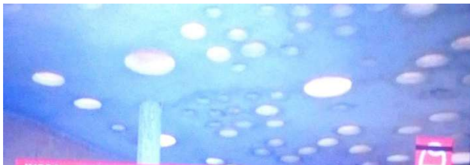
Fig 4 : Système d'éclairage naturel de l'École de Gando
