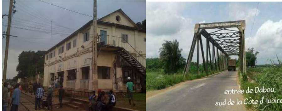
Image 7 : La Gare ferroviaire d'Agboville
