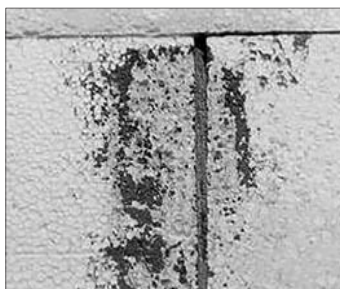
ФИГУРА 15: Пример за неправилно запълване на фугите с лепило
