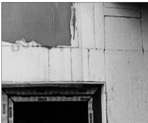
ФИГУРА 14: Пример за неправилно полагане около отвор на топлоизолационни плочи с малки размери, без разминаване на фугите, съвпадение на фугата с ръба на отвора
