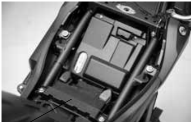
Sicherungskasten im Batteriefach
